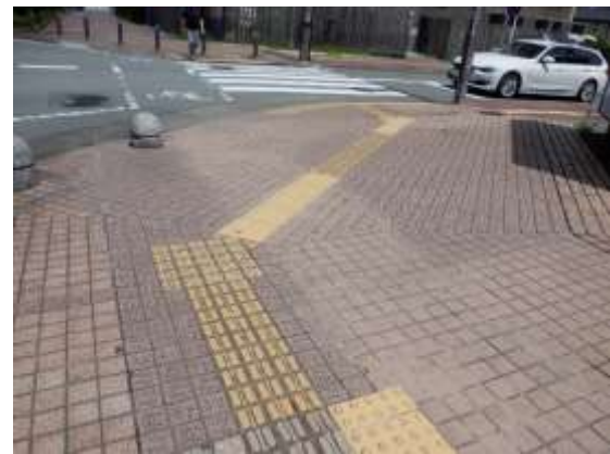
歩道（鳥羽松阪線：県-2） 種類の異なる視覚障がい者誘導用ブロック が混在している。
